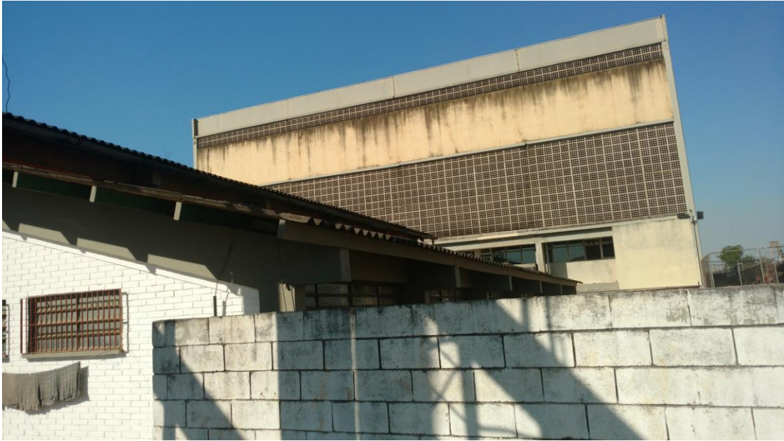
Telhado que será utilizado para captação da água
